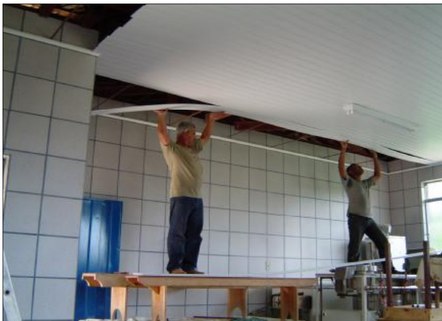
Een nieuw PVC plafond in de eetzaal van de crèche.
